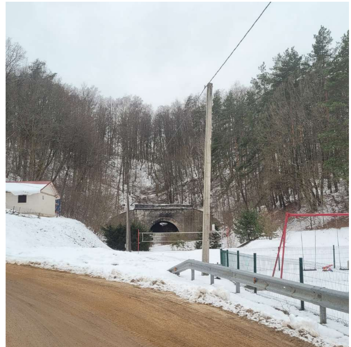
31 pav. Panerių geležinkelio tunelis.
