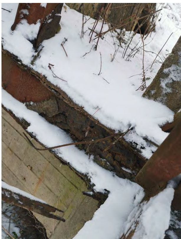
6 pav. Perdangos elementų korozija
