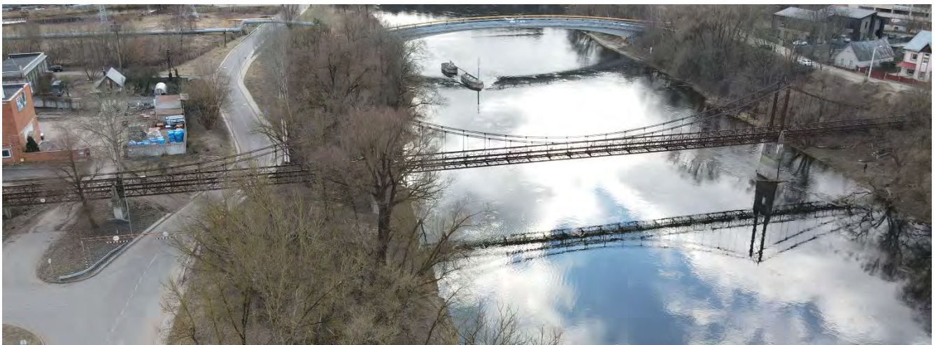
2 pav. Tiltos fasadas (iš aukštupio pusės)
