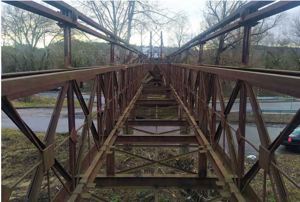
3 pav. Tilto viršaus vaizdas (Elektrinės g. pusėje)
