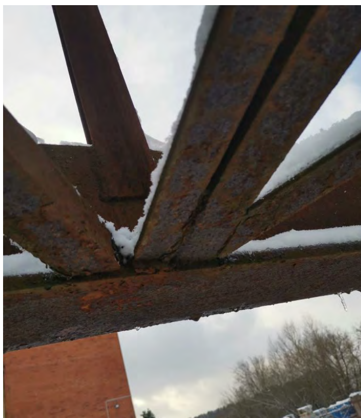
6 pav. Perdangos elementų korozija
