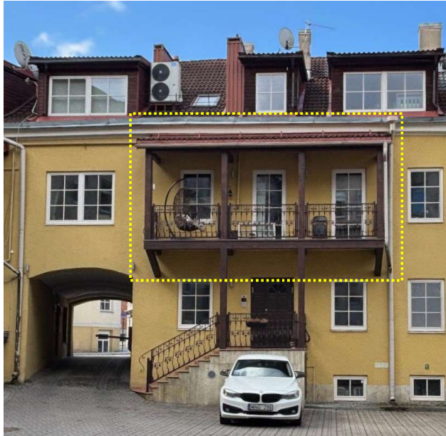
1 pav. Tilto g. 13 ŠR fasadas.
