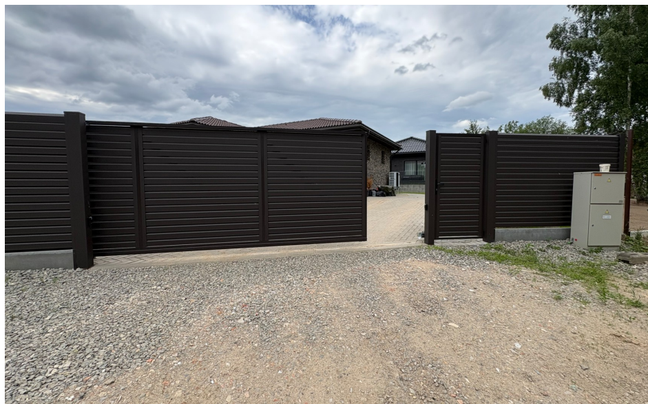
Esama įvažiavimo / išvažiavimo į žemės sklypą Katkų g. 16 vieta iš M. Krupavičiaus gatvės
