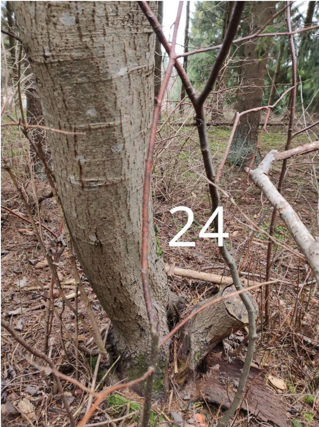
Baltalksnis (Nr. 24 plane) - laja šiek tiek neproporcinga. Išpjautas kodominantinis kamienas. Prasdėjęs šaknų kaklelio puvinys. Rekomenduojama atlikti lajos priežiūros genėjimą ir nuolatinį būklės monitoringą. Ateityje gali būti priimti teikti sprendimą šį medį šalinti.
