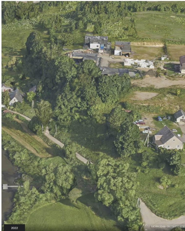
22.4. pav. Esama šlaito 3D situacija šiaurės kryptimi
