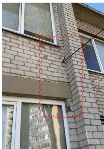
4 pav. Išorinės sienos plyšiai
