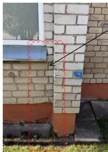
3 pav. Vidinės sienos plyšys, markiruotės sutrūkusios (Nr. 25-10T)
