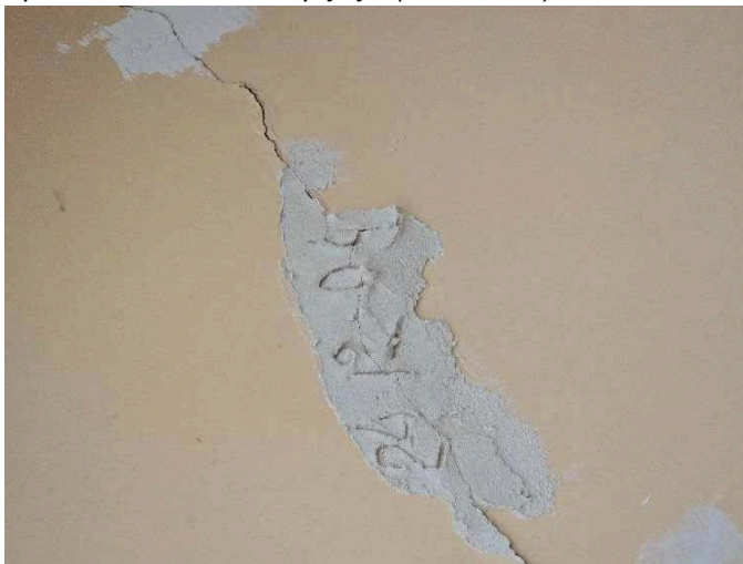
3 pav. Vidinės sienos plyšys, markiruotės sutrūkusios (Nr. 25-10T)
