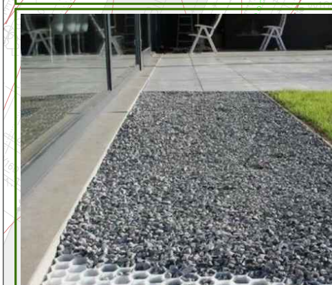
Kiemo ir prieigų takeliai dviejų atspalvių betono trinkelėlių, smulkios frakcijos granito skalda nuogrindai statinių perimetru (analogo pvz.)
