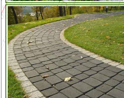
Kiemo ir prieigų takeliai dviejų atspalvių betono trinkelėlių, smulkios frakcijos granito skalda nuogrindai statinių perimetru (analogo pvz.)
