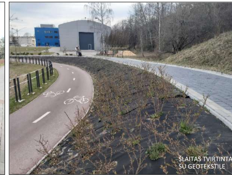
ŠLAITAS TVIRTINTAS SU STAMBIŲ AKIŲ GEOTINKLU
