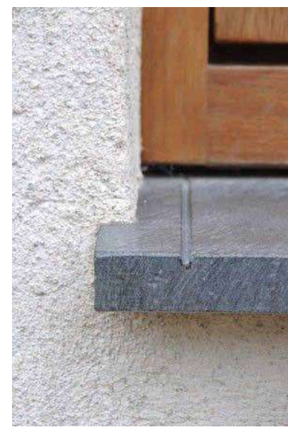
Angokraščių remonto ir apskardinimo pavyzdys
