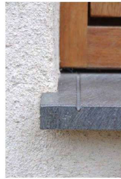
Angokraščių remonto ir apskardinimo pavyzdys
