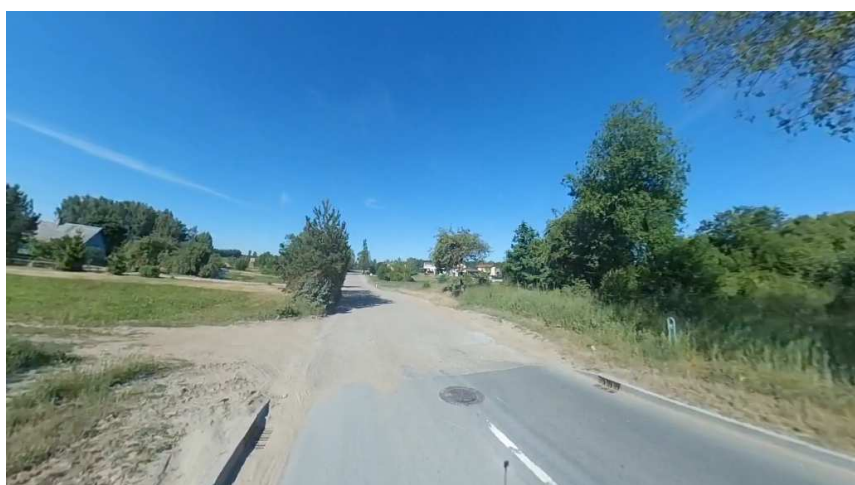
2 pav. Asfaltuoto ruožo pabaiga
