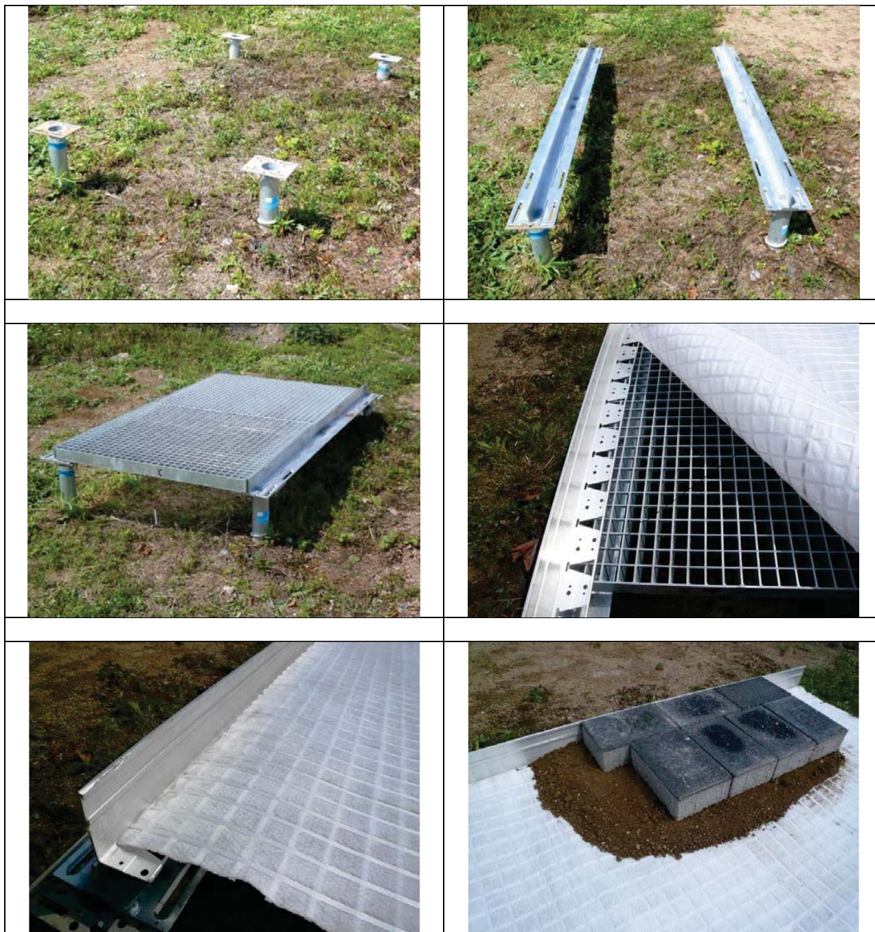
6 pav. dinaminio šaknų apsaugos plieninio tiltelio įrengimo pavyzdys
