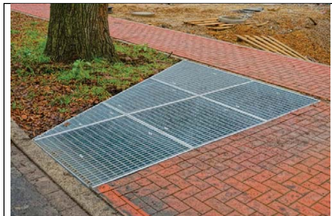
5 pav. dinaminio šaknų apsaugos plieninio tiltelio pavyzdys
