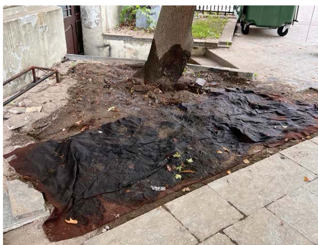
8 pav. Šaknų apsaugos tvarsčio pavyzdys
