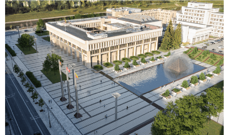
Nepriklausomybės aikštės rekonstrukcija
