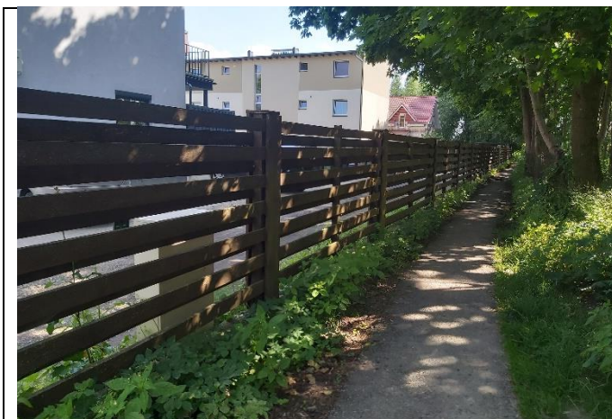
Tako rytinės pusės tvora
