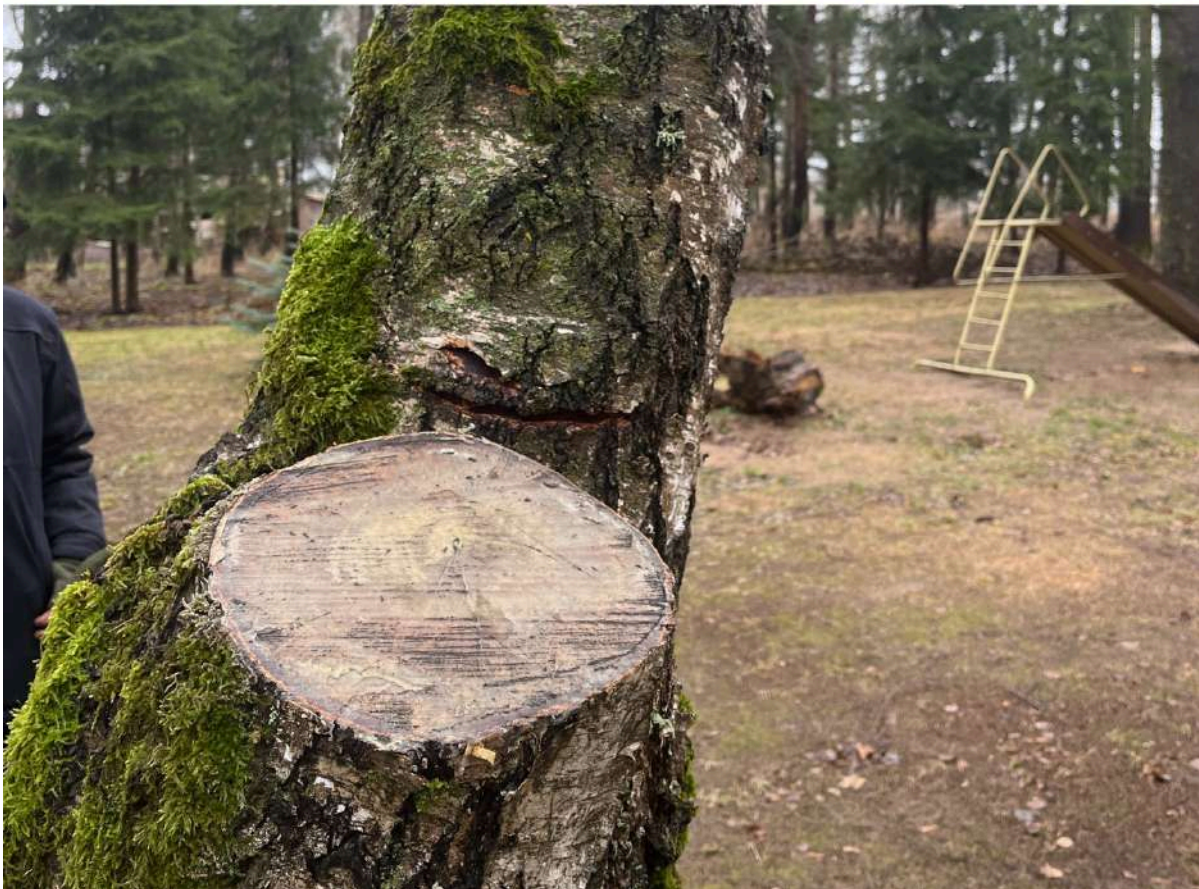
Karpotasis beržas (Nr. 29 plane) - Prasidėjęs puvinys kamienė. Išpjautas kodominantinis kamienas, pjūvio metu padarytas pažeidimas. Rekomenduojamas būklės monitoringas kas 6 mėnesius, būklei blogėjant šalinti.
