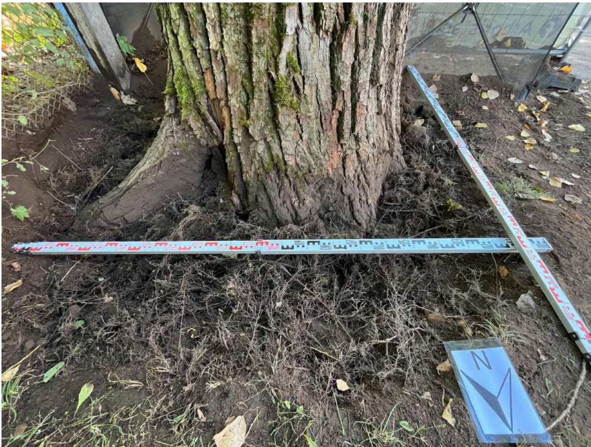
Pav. 4.1.3. Kanadinės tuopos Nr. KT1 šaknų kaklelio mediena sveika, be mechaninių pažeidimų, puvinių ar grybų vaisiakūnių.
