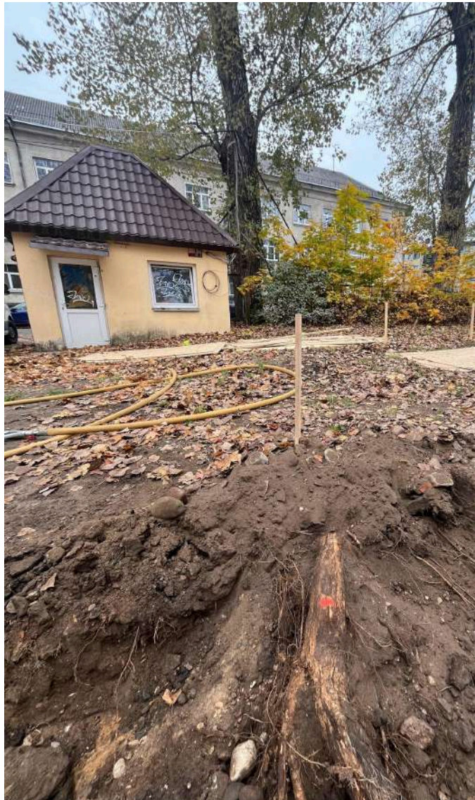
Pav. 4.1.4. Vakarinėje sklypo dalyje buvo aptikta stambių tuopos šaknų, išsidėsčiusių visoje šaknų apsaugos zonoje ir už jos ribų. Raudonas taškas žymi šaknų apsaugos ploto ribą.
