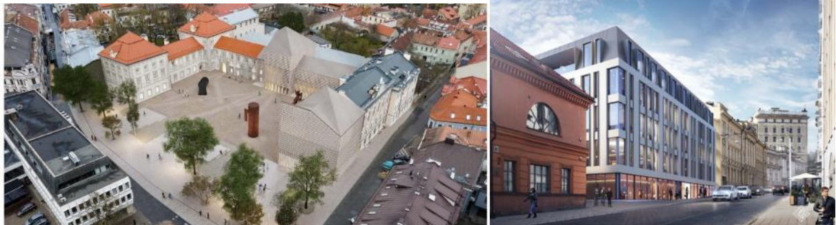
pav. 4 Šiuolaikiškos raiškos architektūra istoriniame kontekste. Autoriai - „Processoffice“, „Archinova“
