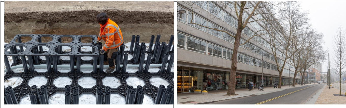
3 pav. Šaknų orinimo sistema įrengimas, gerinant gatvės medžių augimo sąlygas
