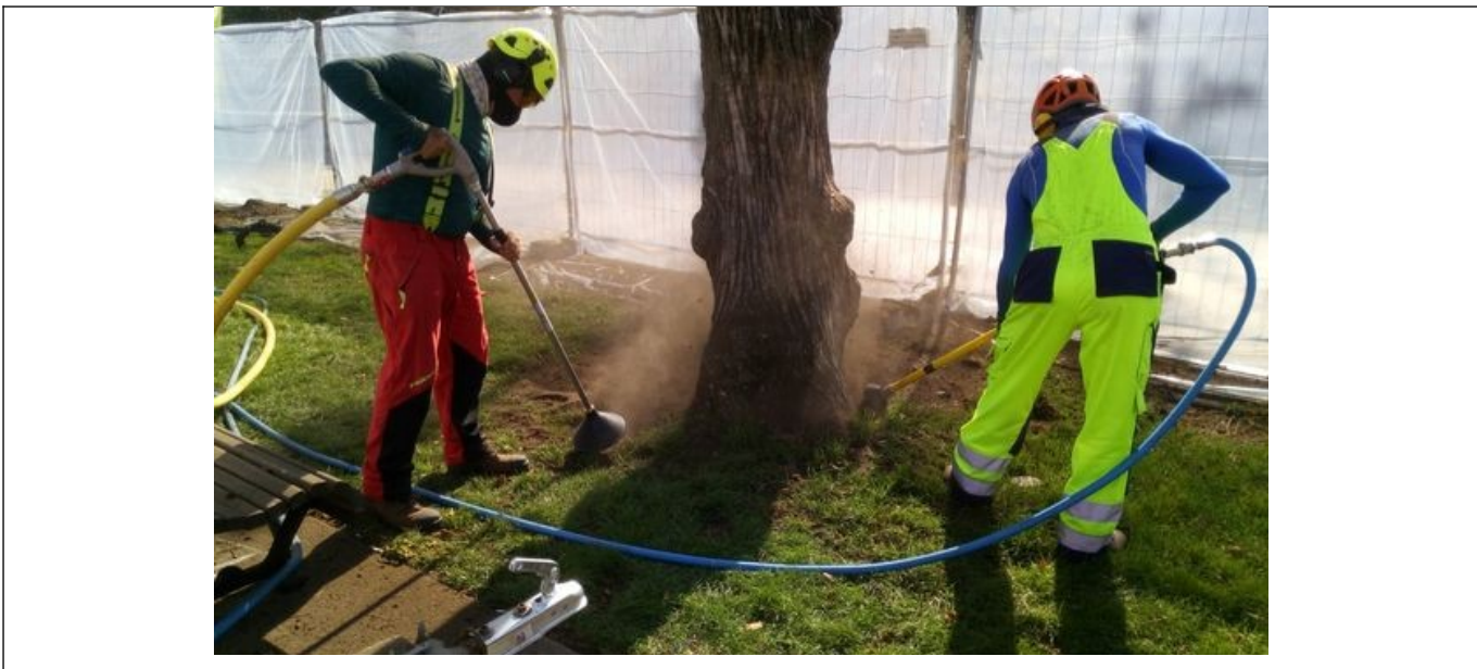
2 pav. Medžio šaknų atkasimas oro kastuvu
