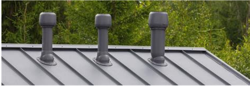
Pav.7. Ventiliacinių kaminėlių pavyzdžiai
