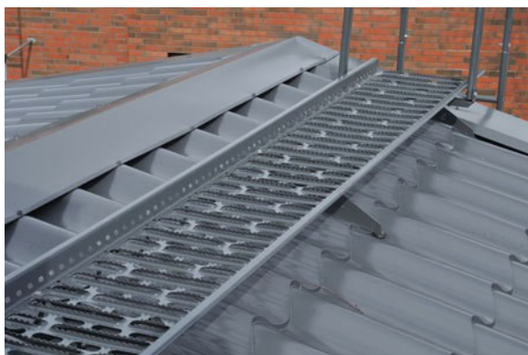
Pav.2. Stogo tiltelio pavyzdys
