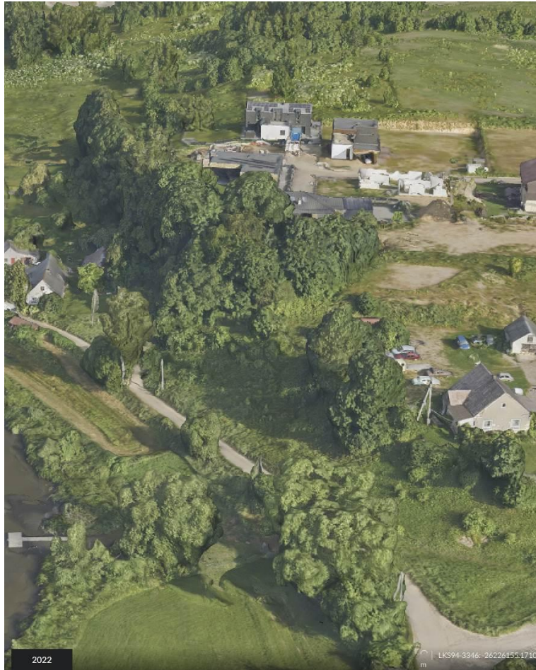
22.4. pav. Esama šlaito 3D situacija šiaurės kryptimi
